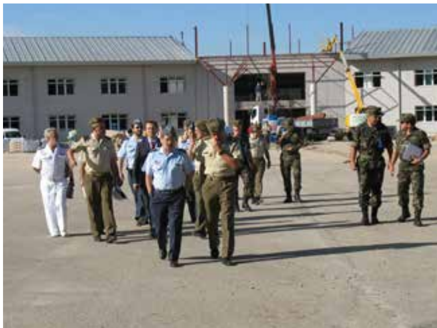
Viendo el desarrollo de las obras del edificio de Cuartel General de la UME. Septiembre de 2006
